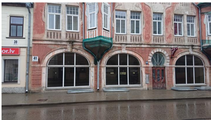
Foto Nr.5 Nav uzstādītas ūdens novadīšanas renes lietūs ūdens atvadīšanai no ēkas.
