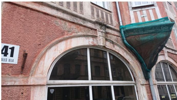
Foto Nr.9 Erkers - dzelzsbetona. Uz galvenās ēkas fasādes
