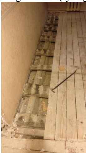
Foto Nr.21 Koka grīdas konstrukcija
